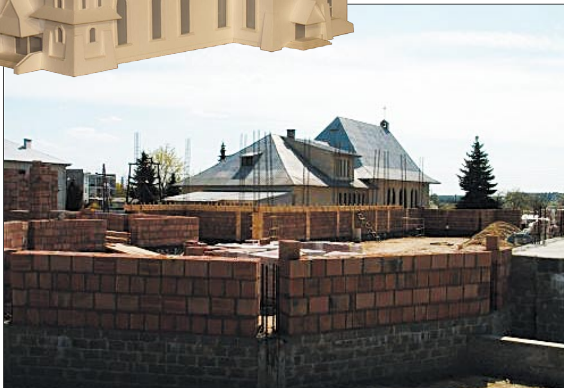
Kościół w budowie
