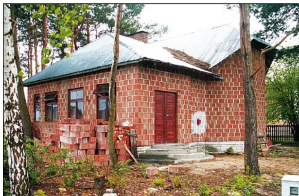
Kaplica w Dereźni - w budowie
