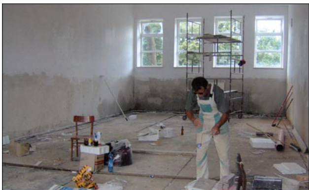
Remont małej sali gimnastycznej z WZZiO w Biłgoraju
