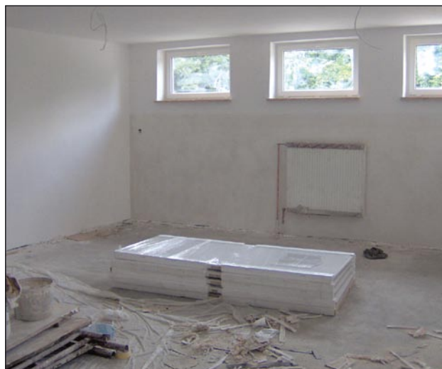
Remont siłowni w ZSZiO w Biłgoraju
